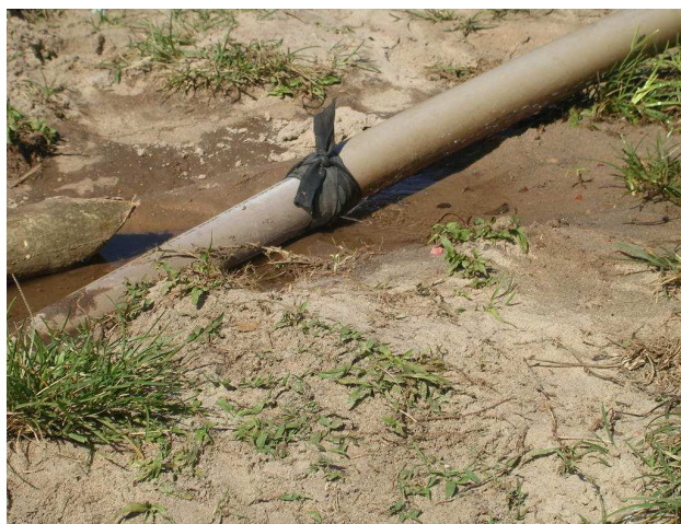
Figure 8 - Réparations sommaires des fuites le long de l'adduction
